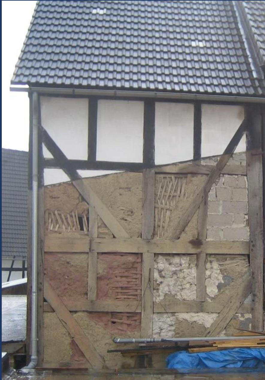
Fachwerkkonstruktionen wurden oft ungeschlüssig ergänzt. Am dauerhaftesten sind die alten Holzlehmkonstruktionen. In Hallenberg sind diese oft fachgerecht erneuert worden und sind jetzt wieder für lange Zeit in Takt.
